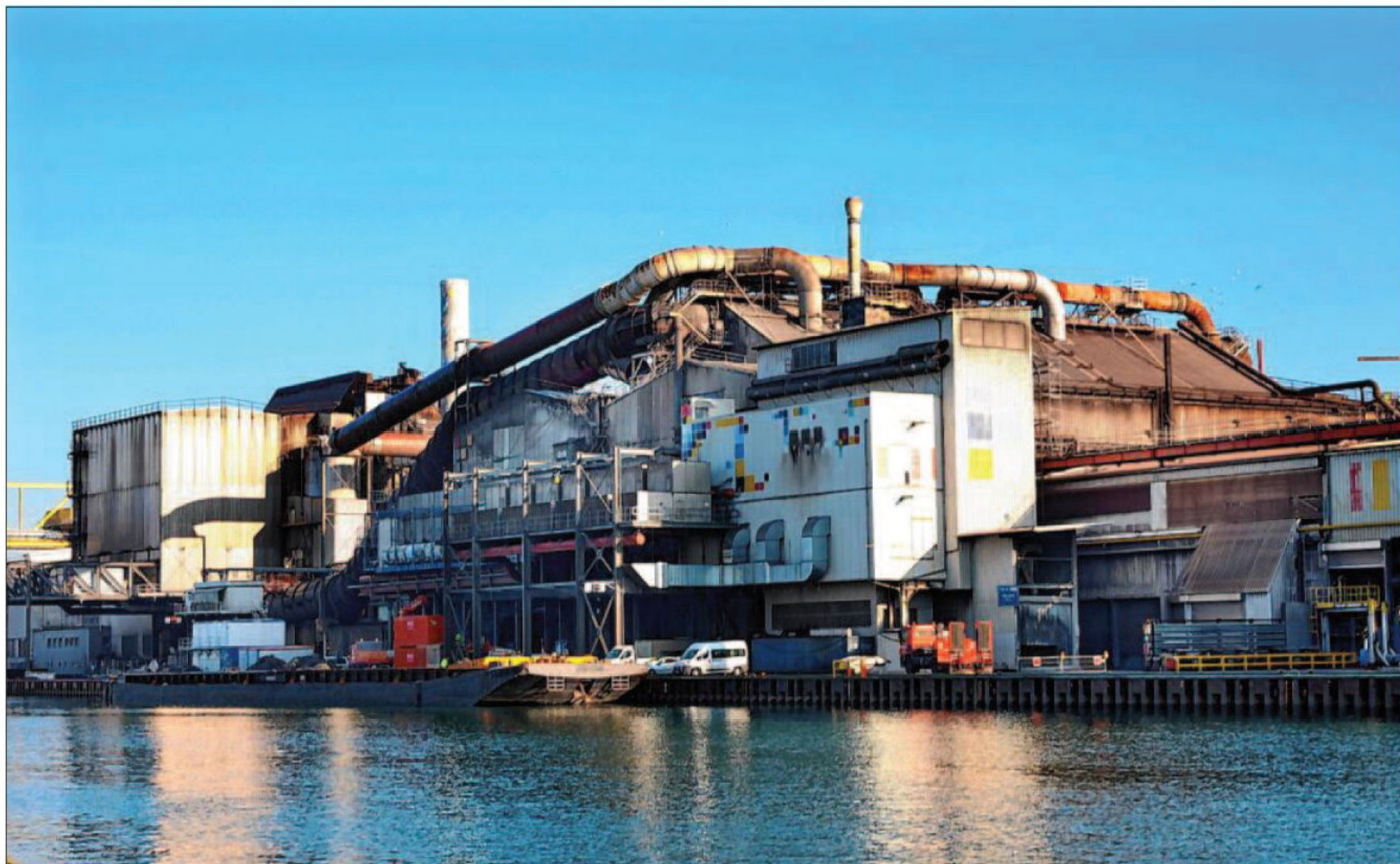
Vorzeigeprojekt in Sachen Klimaschutz: Die Abwärme der Badischen Stahlwerke soll zukünftig etwa 7000 Haushalte im grenzüberschreitenden Ballungsraum mit Wärme versorgen.
